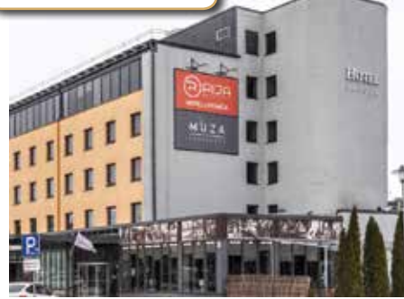
SIA “Pilger”, Slimnīcas iela 7, Bauska. ○
